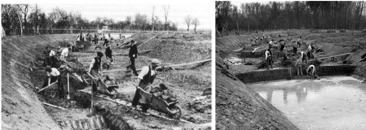
Obr. 1 a 2: Výstavba Baťova kanálu
