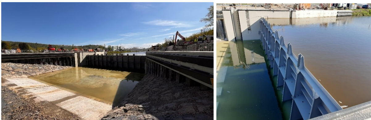
Obrázek 3 a 4: Definitivní uzávěr plavebního kanálu Troja
