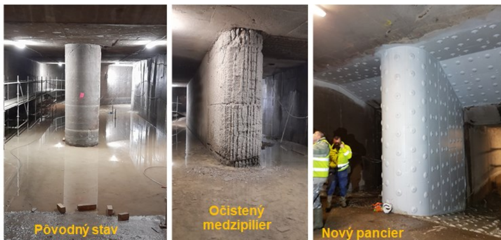
Obr. 13: Opancierovanie najviac namáhaných častí medzistienok kanálového systému
