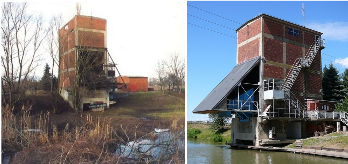
Obr. 8 a 9: Obnova Výklopníku Sudoměřice
