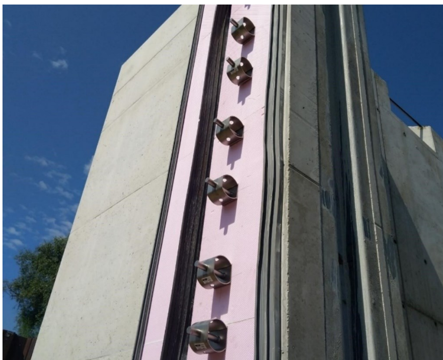
Obr. 4 Nerezové smykové trny v dilatačních spárách plavební komory
