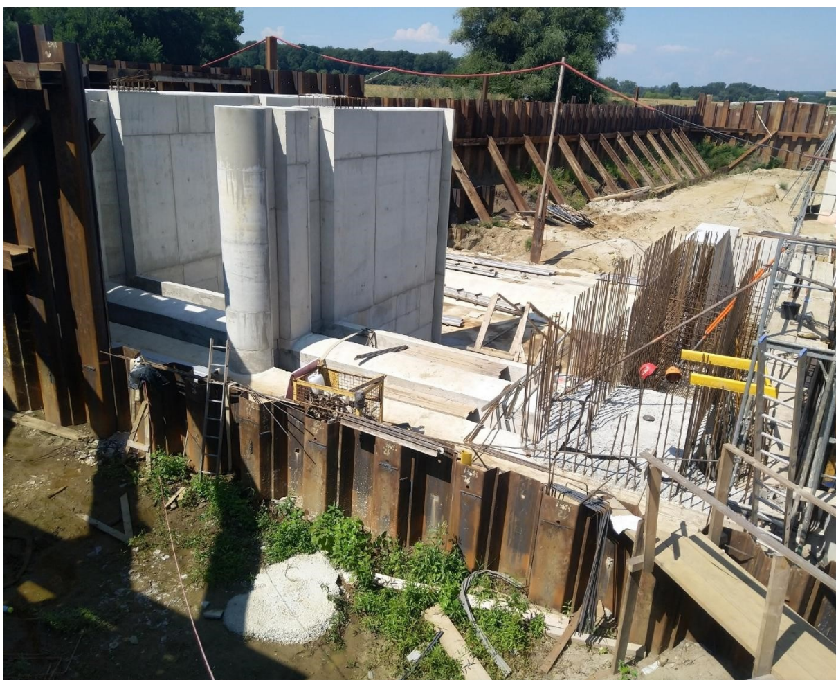
Obr. 7 Postup výstavby jezu z horní vody (armováno pravého pilíře)
