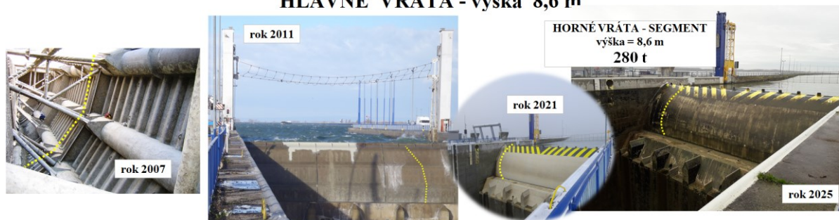
Obr. 4: Porovnanie pôvodnej a súčasnej konštrukcie hlavných horných vrát PLK-G
