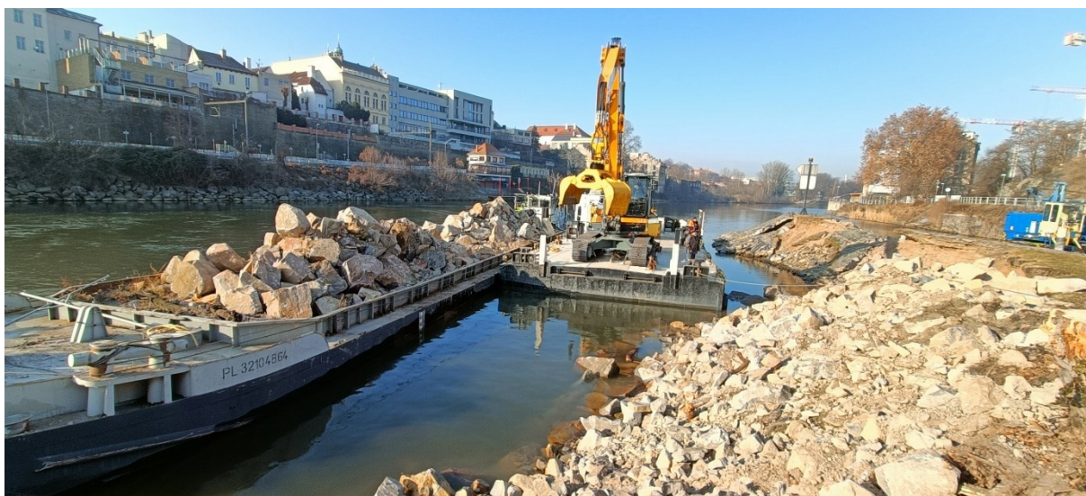
Obr. 3. Oprava úpravy toku v lokalitě Kolín.
