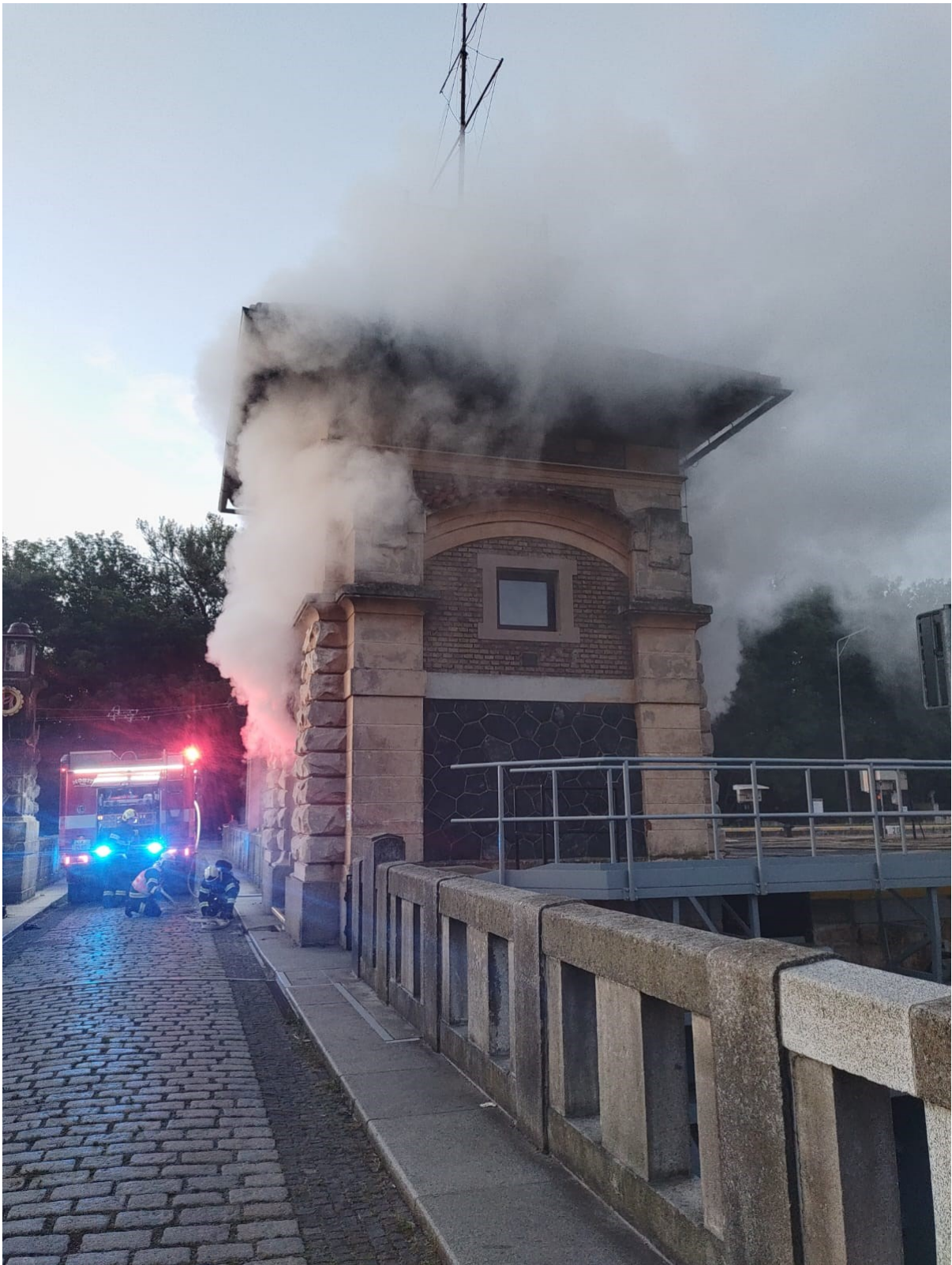
Obr.1: Požár velínu plavební komory Hořín
