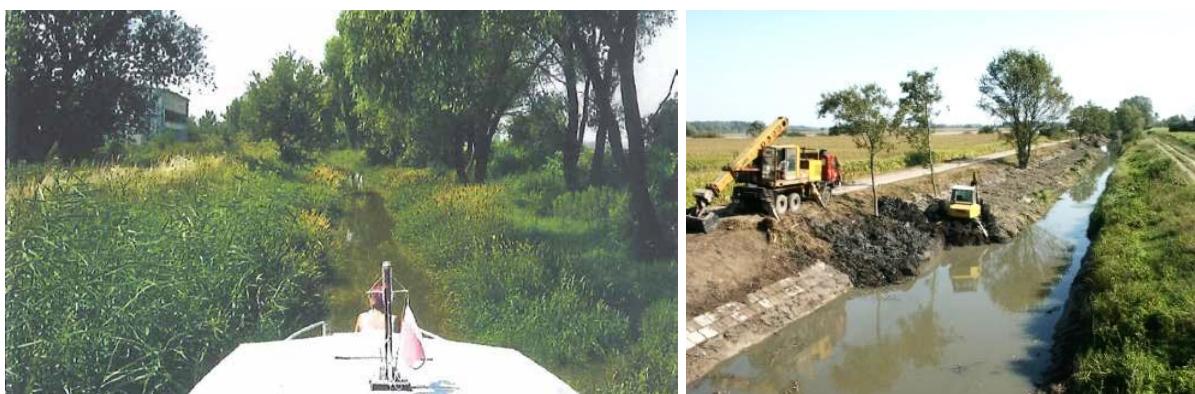
Obr. 6 a 7: Obnova úseku Petrov - Sudoměřice
