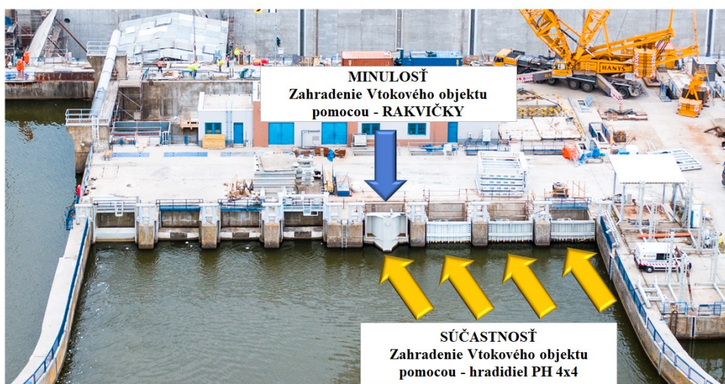
Obr. 7: Provizórne hradenia vtokového objektu
