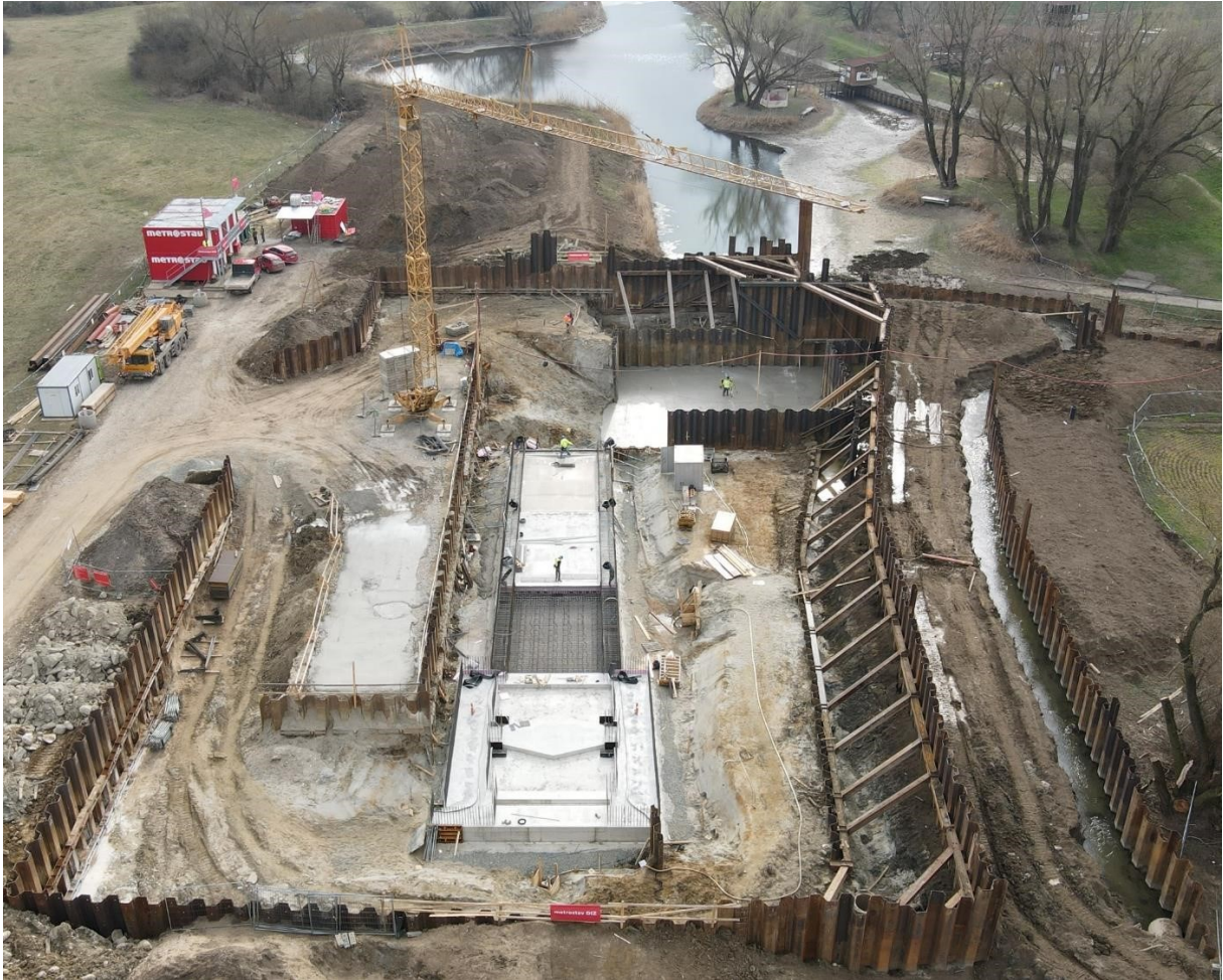
Obr. 9 Záběr na stavební jímku z dolní vody (vpravo provizorní přeložky Radějovky do otevřeného kanálu, vpravo nahoře základová deska jezu, uprostřed základové díly PK, nejnižší dolní ohlavi) (zdroj: Metrostav DIZ s.r.o.)
