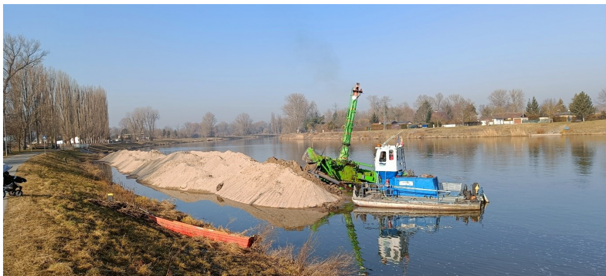
Obr.2: Hloubení dna pomocí podvodního dozeru v lokalitě Čelákovice
