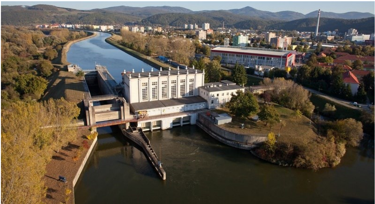
Obr. 10 VD Trenčín s rozostavanou PLK. Foto Slovenské elektrárne, a.s.
