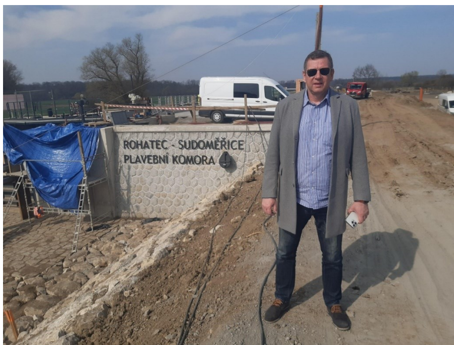
Obrázek 4 – Výstavba plavební komory Rohatec – stav v květnu 2025 (zdroj MD)
