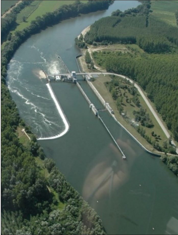
Obr. 13 VD Selice - zľava pevná hať, pole pohyblivej hate, MVE, PLK. Foto autor
