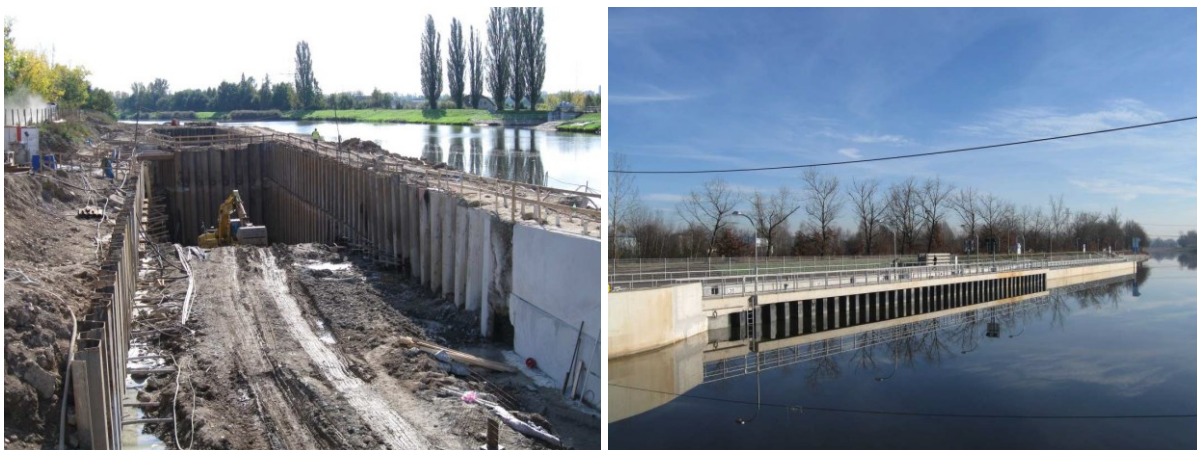
Obrázek 1 a 2: Zajištění stavební jámy, dokončená PK České Vrbné
