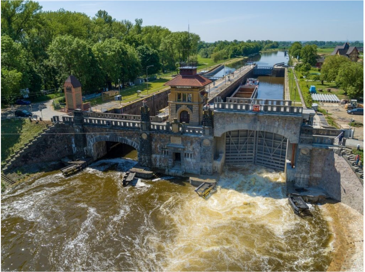
Obr.3: PK Hořín se zdviženým mostem
