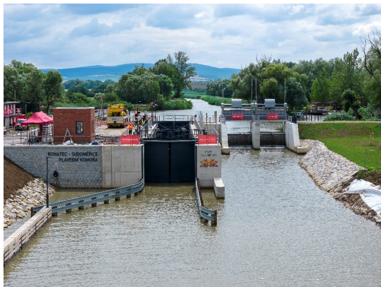
Obr.3: Celkový pohled na stavbu plavební komory Rohatec/Sudoměřice
