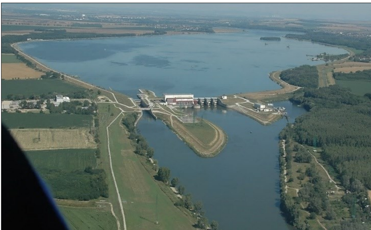
Obr. 12 VD Kráľová – zľava PLK, VE, hať, prístav, v pozadí Zdrž Kráľová. Foto autor.
