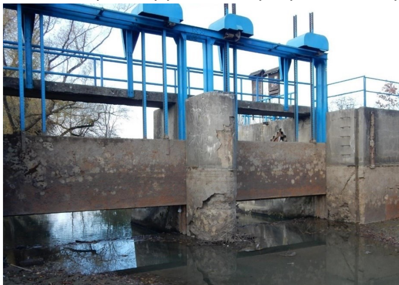
Obr. 5 Původní čelo jezu z vypuštěné zdrže
