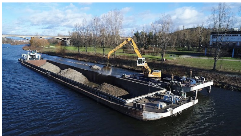
Obr. 7: Prohrábky plavební dráhy na Vltavě
